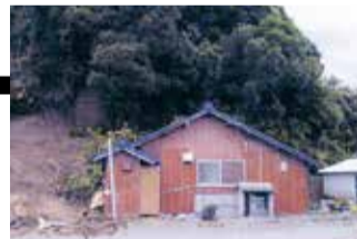
がけ地の崩壊等の恐れのある土地に建っている危険住宅
